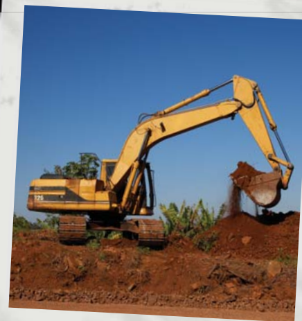
Les excavatrices sont de gros engins réservés aux travaux lourds.
