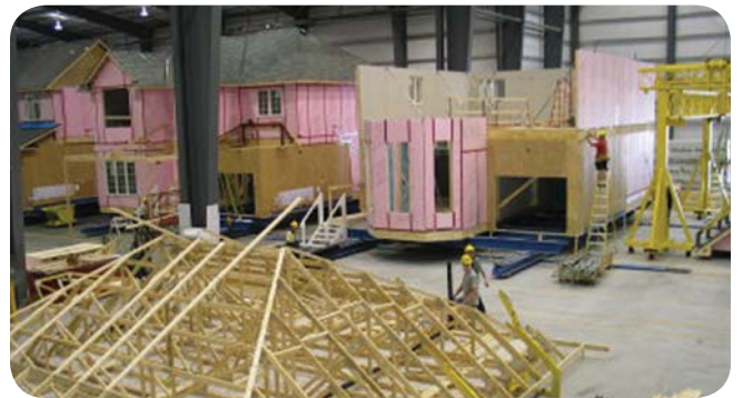
Figure 3 L'assemblage des toits sur le plancher est moins dangereux pour les couvreuses et couvreurs.
