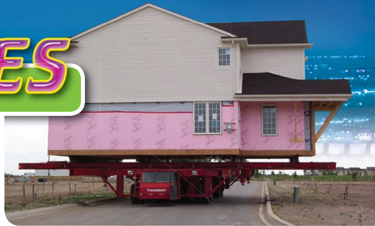
Figure 2 Une maison terminée quitte l'usine, transportée par camion.
